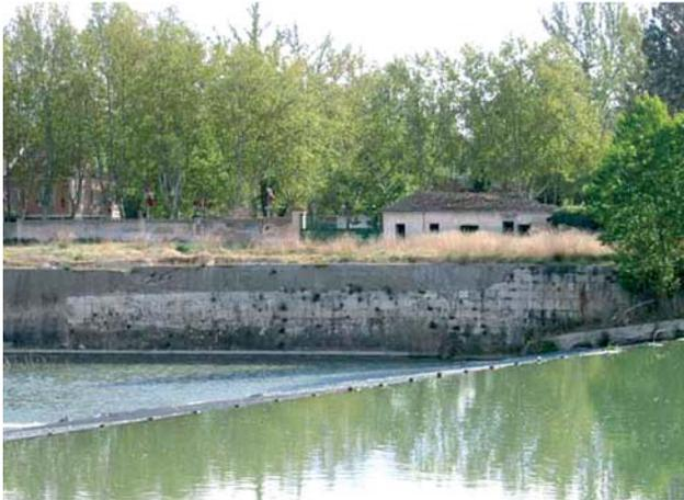
**Izquierda.** Vista del azud sobre el Tajo, junto a palacio. Al fondo la única edificación que se ha dejado en pie de la fábrica de "Harinas El Puente". En el espacio entre el dique y la entrada aún se observan el caz y socaz con parte de las compuertas.
