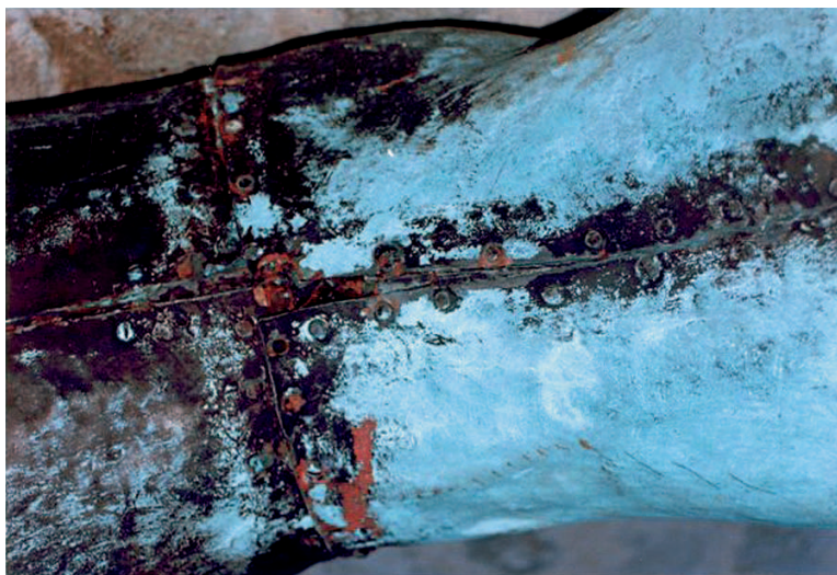
Fig. 5. Unión de las placas de bronce con remaches de la misma aleación.
