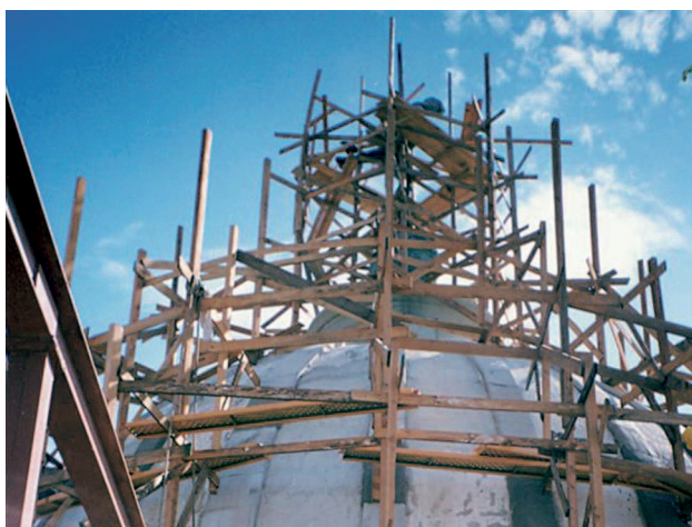
Fig. 4. Vía de acceso a la cúpula del edificio.
