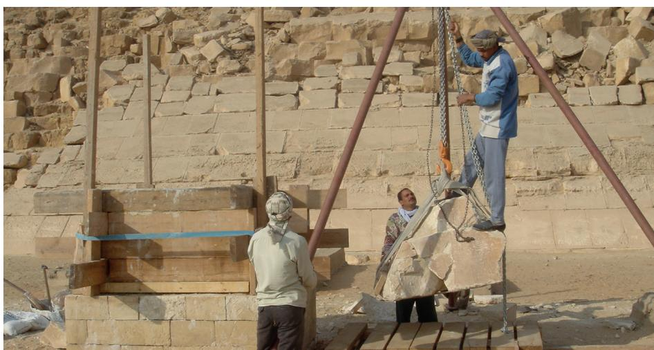
**Imagen 7.** Sistema de orientación para el montaje con cuerda de lino que marcan los ángulos y las aristas.
