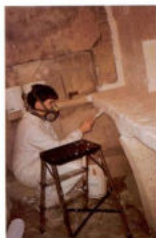
3. Realización del molde del muro con mesa adosada. Aplicación de la fibra de vidrio amorfa y del látex.
