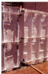
7. Ensamblaje de los muros por su parte posterior.
