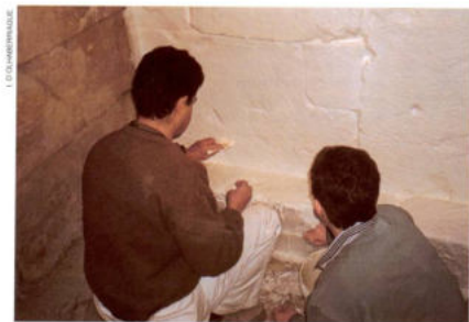
2. Realización del molde de uno de los muros con banco corrido. Aplicación del látex con velo de fibra de vidrio.
