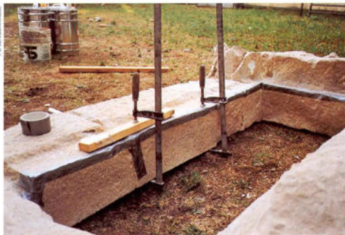
8. Unión de las dos partes de uno de los vanos interiores.
