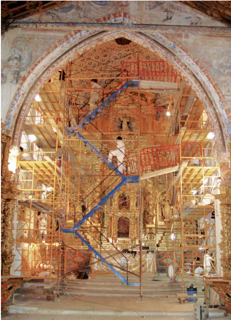
Vista general de la cabecera en pleno proceso de restauración.
