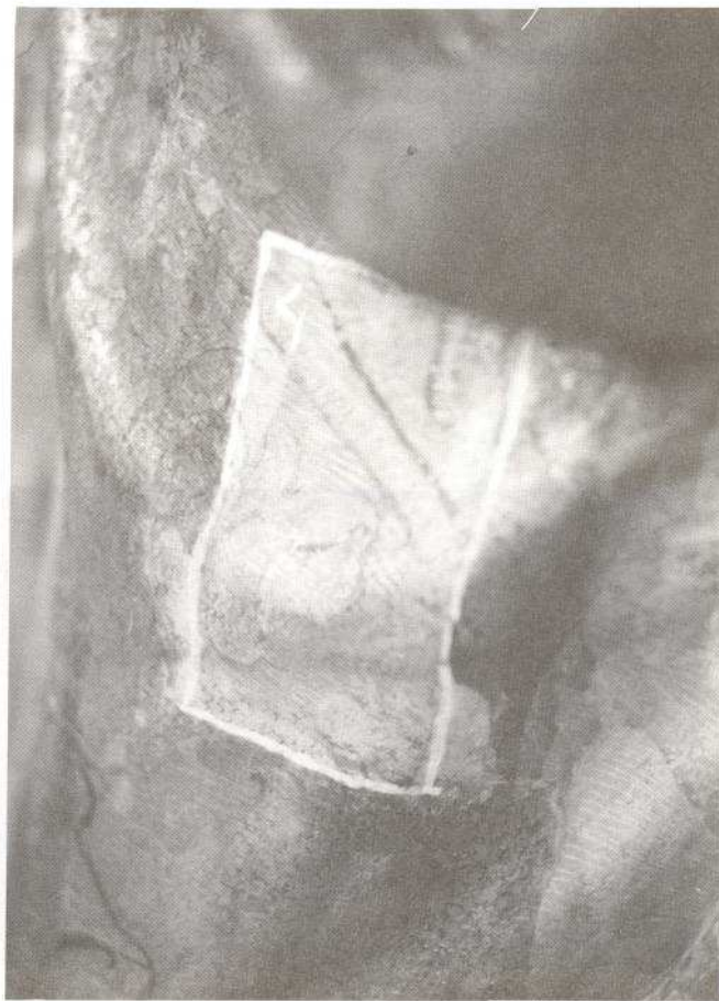
Figura 12. Cala de limpieza en la zona del manto.
